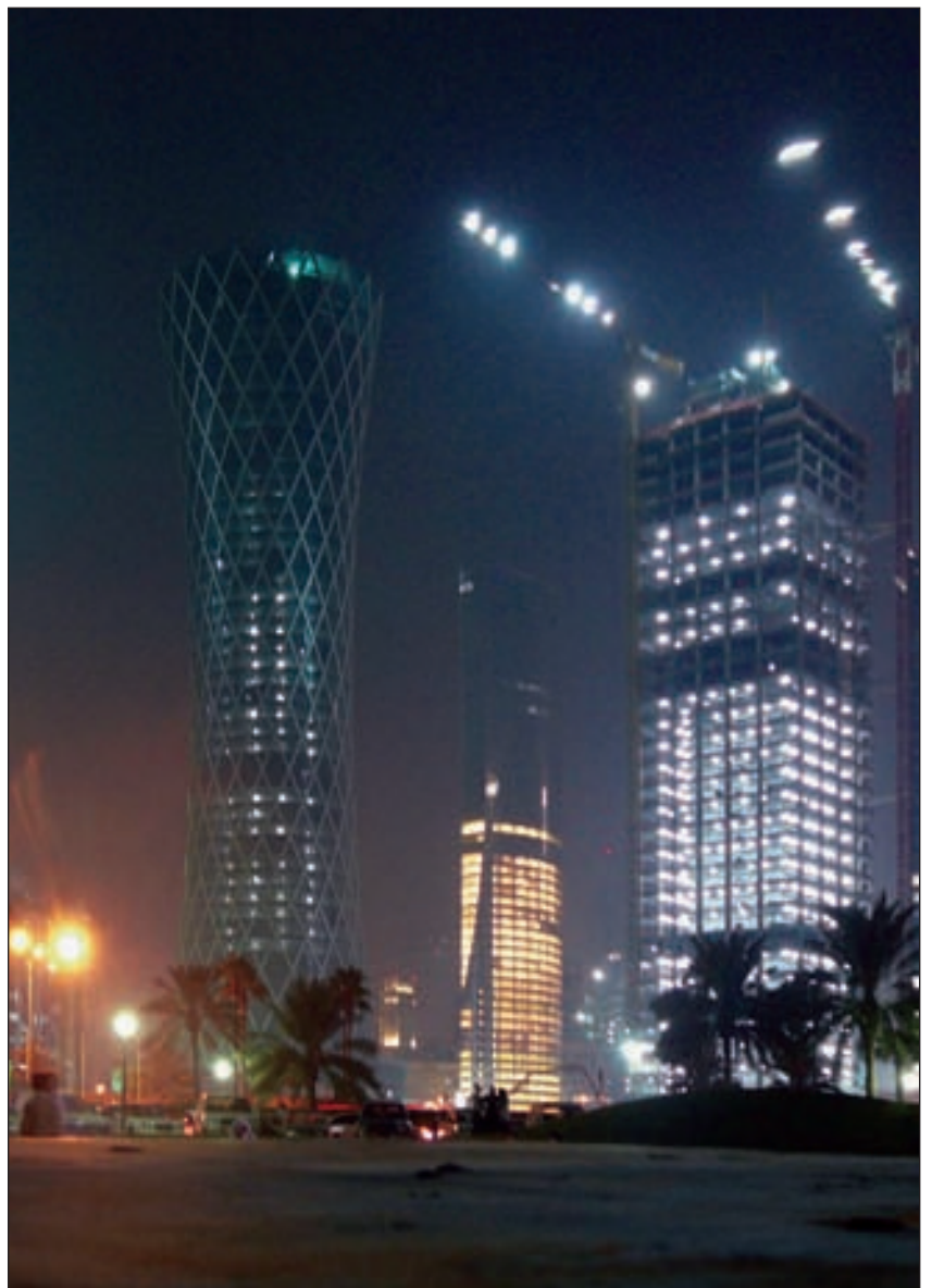
Figuur 4. Bouwplaats in Qatar bij nacht.
